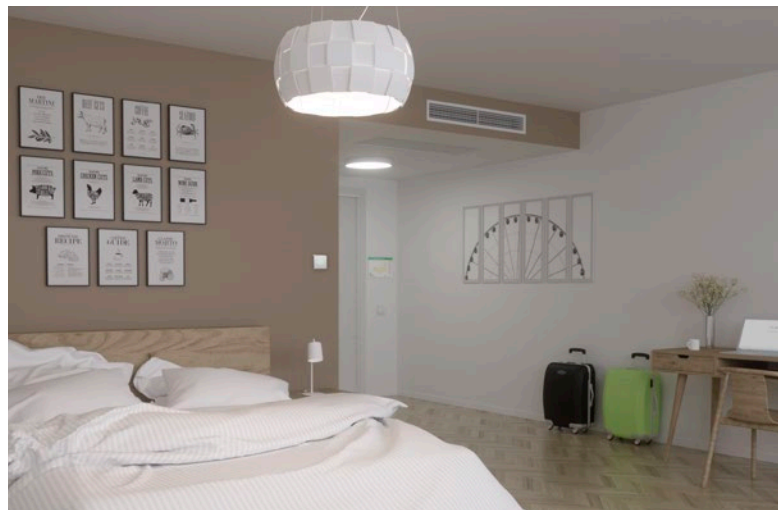
Hotellihuone, jossa on asetusarvon valintayksikkö, vesikiertoinen jäähdytys ja -lämmitys sekä tarveohjattu ilman säätö. Avainkorttipidin läsnäoloa varten.
