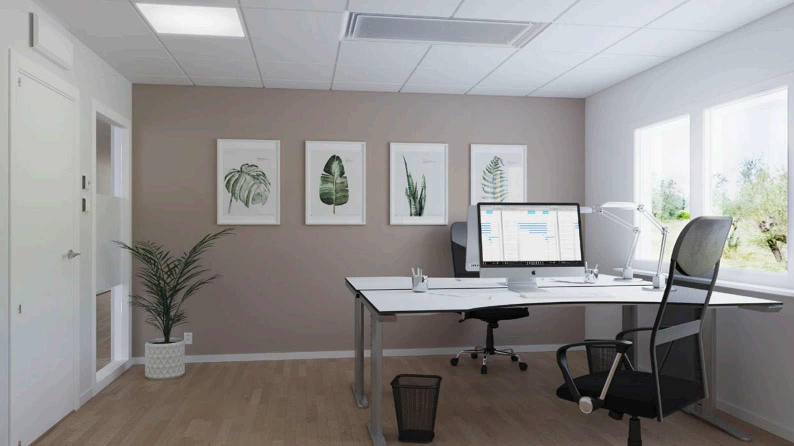
Vesikiertoinen toimisto, jossa on asetusarvon valintayksikkö ja läsnäolotunnistimet tarveohjattua ilmanvaihtoa, jäähdytystä ja lämmitystä varten.
