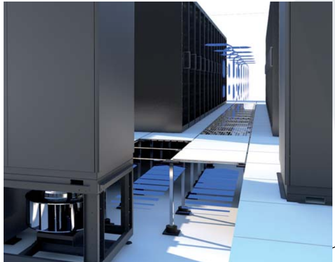
Klimaschränke mit Ventilatorsockel im Doppelboden
