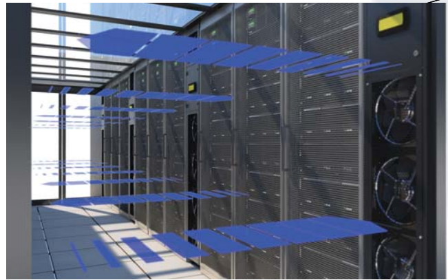
Luftverteilung im Kaltgang
